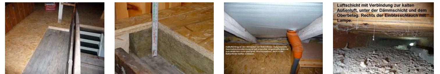
Beispiel einer vermeintlich gedämmten Geschoßdecke, bei der die Kaltluft unter der Dämmung zirkuliert und wir anschließend gefragt werden, weshalb der gewünschte Effekt nicht eintritt. Teuer, wirkungslos und immer wieder so vorzufinden.
