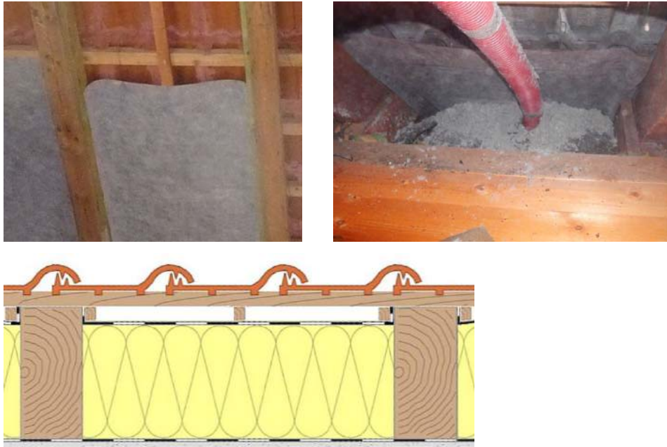
Abbildung 9: nachträglich feldweise eingezogene Unterspannbahnen
