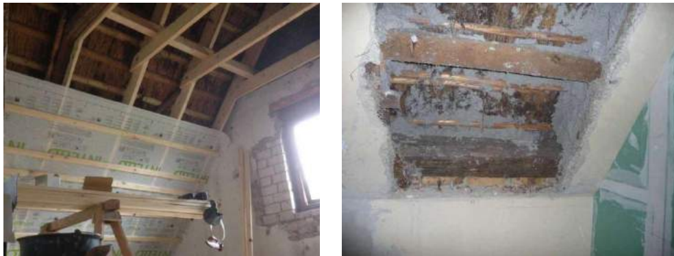
Abbildung 10: Direkt beflochtetes Reetdach
