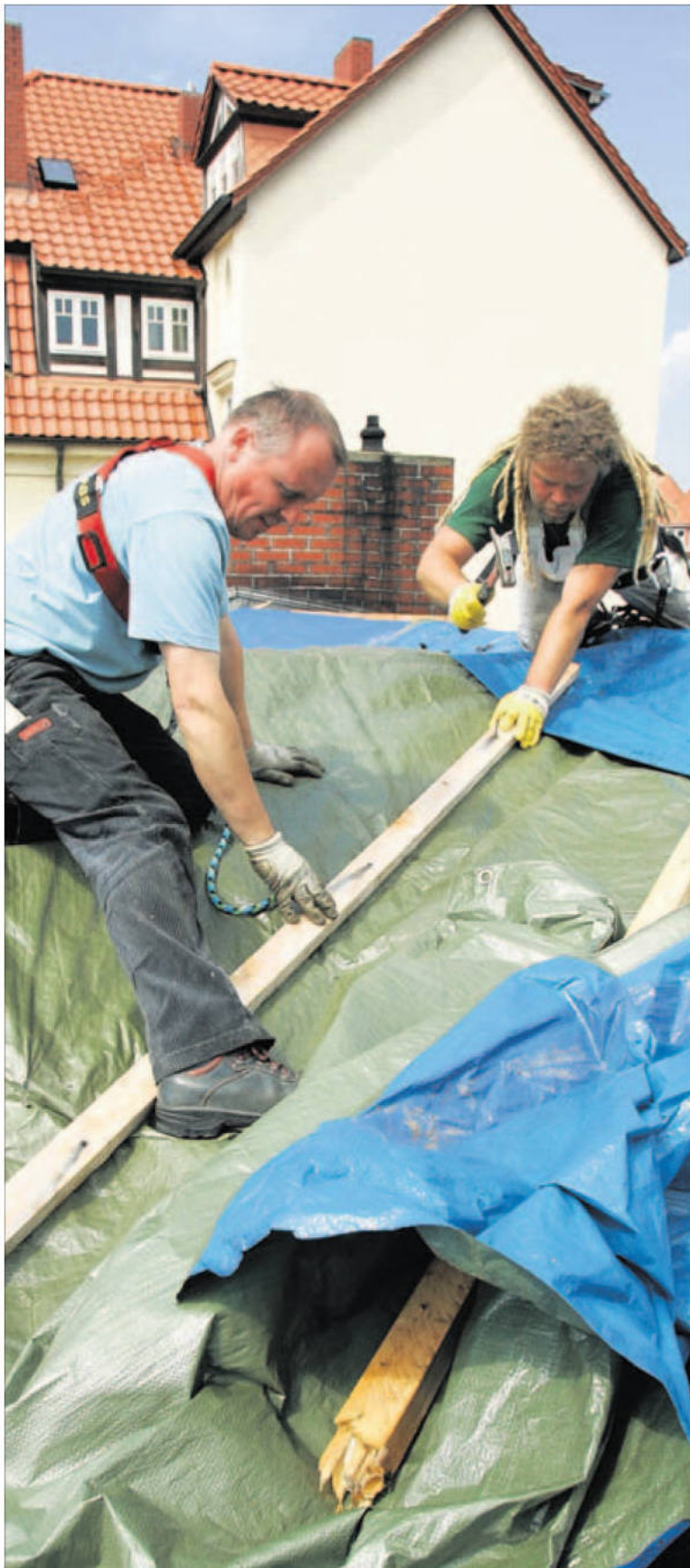
Ramon Bahls (l.) und Heino Jührendt dichteten bis Montag mit Latten und Planen das vorher löchrige Dach des Hauses ab. Foto: Hartmut Klonowski
