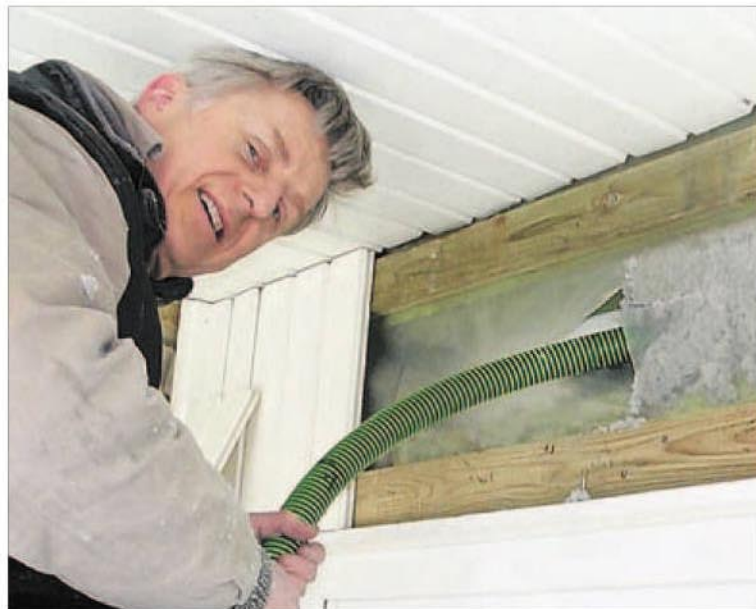
Christoph von Stein arbeitet in seiner Schöne Alte Häuser GmbH mit einem neuen Einblasdämmverfahren für Dächer und Geschossdecken. Foto: privat
