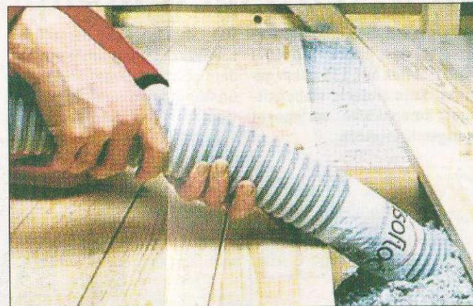
*Einblasdämmung ist ein äußerst schnelles und sauberes Verfahren, das sowohl im Alt- als auch im Neubau angewandt werden kann.*
